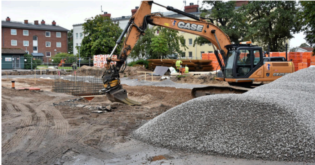
I kvarteret Häggen på Linehed bygger Kvartilen fastigheter och Wästbygg bygg ett 30-tal plusbostäder. Bild: Anna-Karin Forsberg
